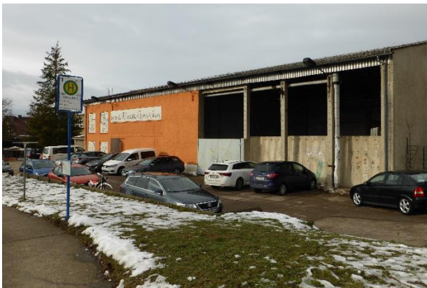
Abb. 88: Altes Heizhaus mit Vorplatz (Quelle: eigenes Archiv)
