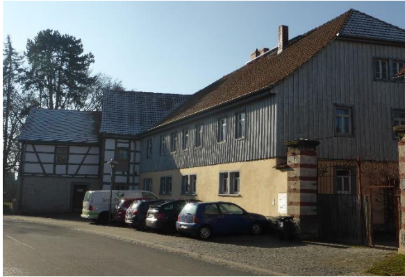
Abb. 79: Gehöft der Untermühle (Quelle: eigenes Archiv)
