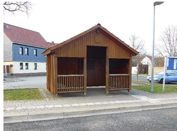
Abb. 42: Überdachte Bushaltestelle an der Weimarischen Straße (Quelle: eigenes Archiv)
