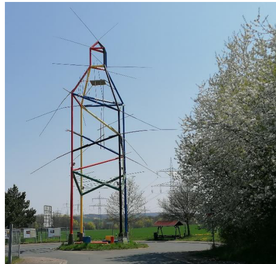
Abb. 44: Feininger-Turm Mellingen (Quelle: eigenes Archiv)
