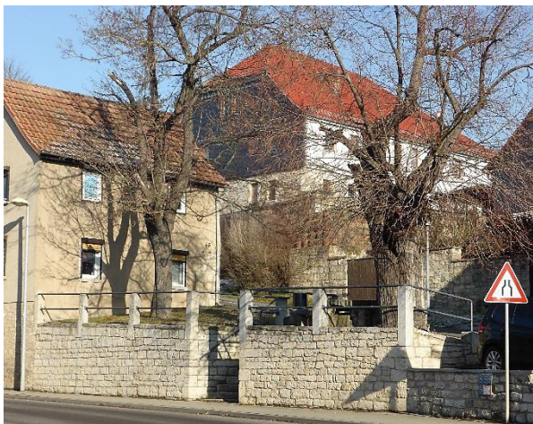
Abb. 65: Natursteinmauer am Schenkbrunnen (Quelle: eigenes Archiv)
