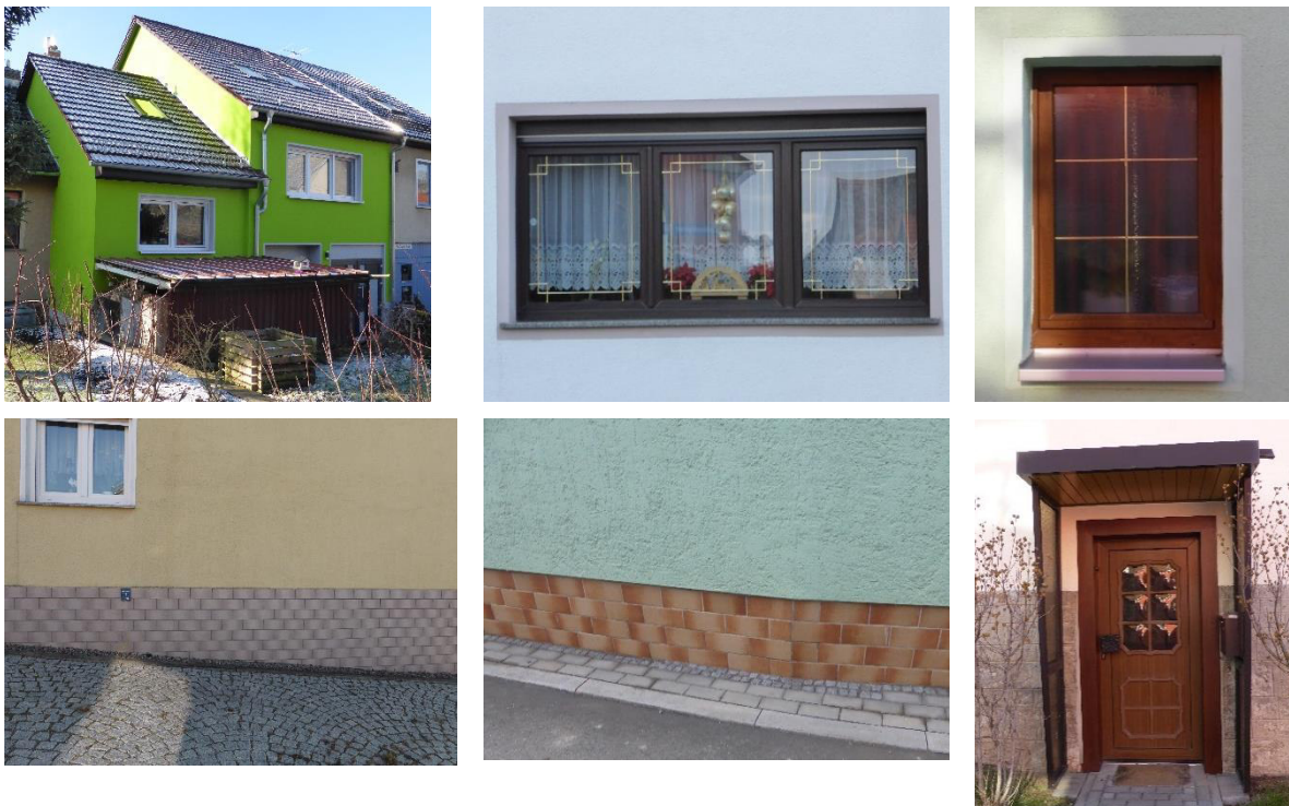
Abb. 92 bis 97: Gestalterische Mängel an Gebäuden (Quelle: eigenes Archiv)
