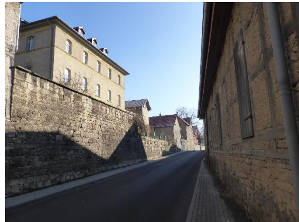
Abb. 99: Engstelle Weimarische Straße auf Höhe der Kirche (Quelle: eigenes Archiv)
