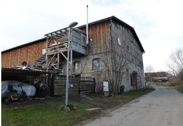
Abb. 21: Ehemaliger Gutshof im Ortskern (Quelle: eigenes Archiv)
